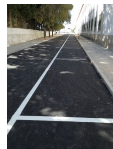
Depois de Execução
