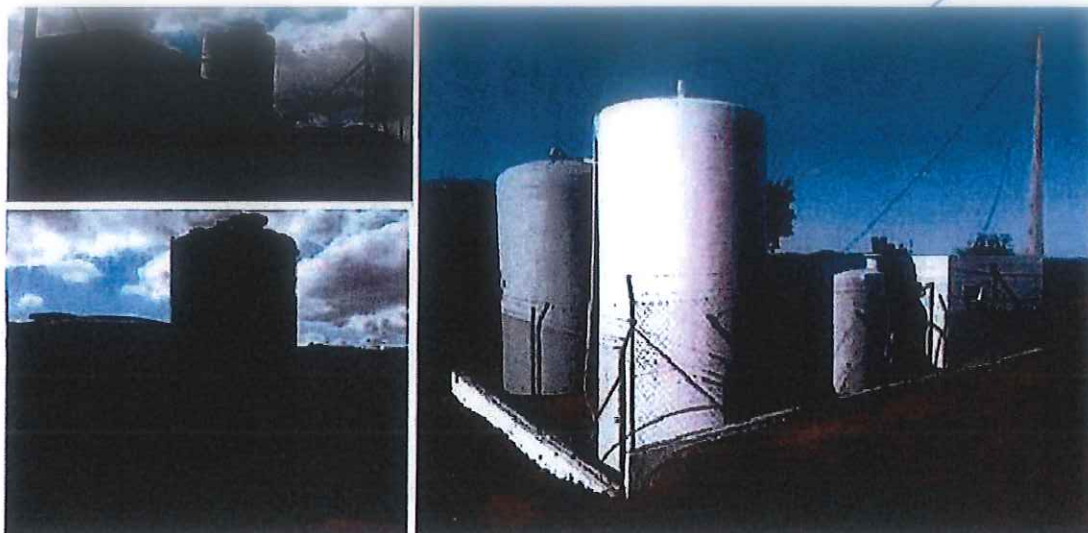
ETA de Cachopo
