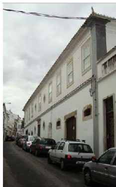
TIPO DE ARQUITECTURA Civil
