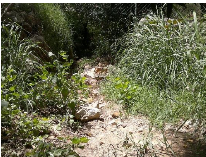
FIGURA 1 | Vala de drenagem a Norte da ER125.
